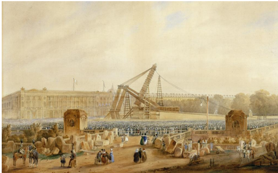
Érection de l'obélisque de Louxor à Paris sur la place de la Concorde.
